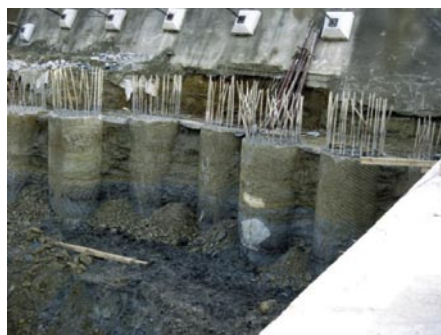
Slika 6 • Piloti desne stene pokritega vkopa z zaščito desne brežine
