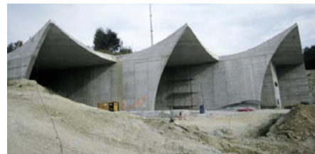
Slika 2 • Zahodni portal pokritega vkopa
