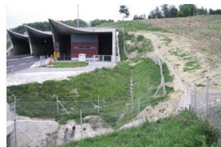
Slika 12 • Zahodni portal pokritega vkopa s pogonsko centralo ter površinsko odvodnjavanje v območju pogonske centrale in portalov pokritega vkopa
