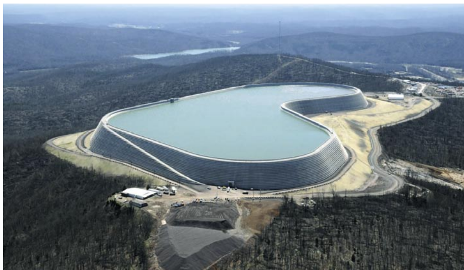
Slika 7 • Pogled iz helikopterja na 37 m visoko in nad 2 km dolgo pregrado Taum Sauk v ZDA, zgrajeno v dveh letih in pol. Vir: http://www.stlsi.com
