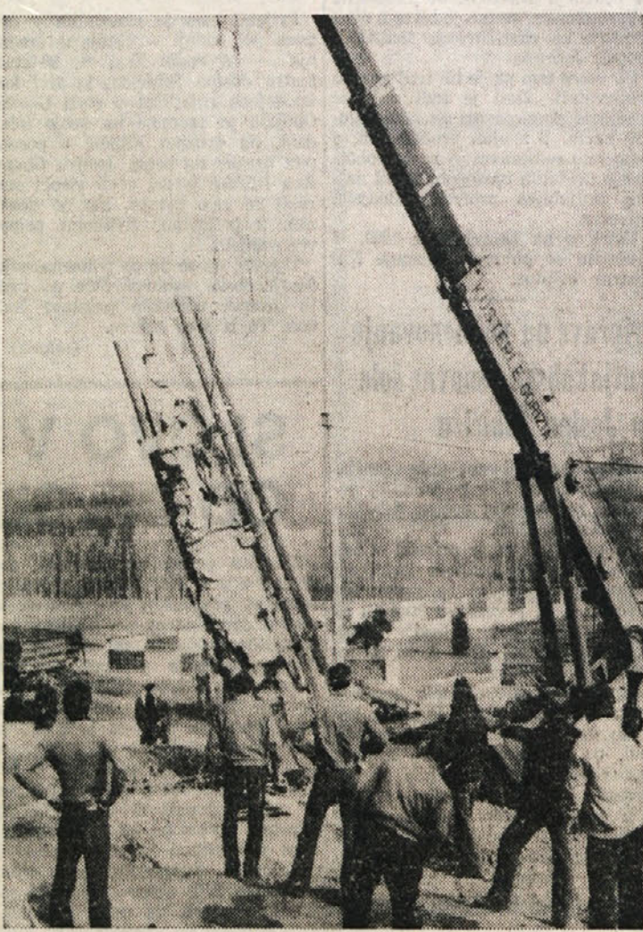
Polaganje kraškega kamna v žerjavom v cementni temelj v Gabrijah
