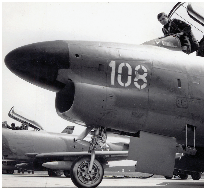
Alojz Terbovc v letalu F-86D 14108. Platišče sprednjega kolesa je pobarvano s srebrno barvo, ki sega tudi na bočne stranice pnevmatike. Po vsej verjetnosti je prej kot za malomarnost šlo za zaščito pnevmatike pred sončno svetlobo. Pozorni maketarji bodo opazili, da so na letalih F-86D v JVL na sprednjem kolesu uporabljali vsaj štiri različne tipe platišč. (Foto: arhiv družine Terbovc)
