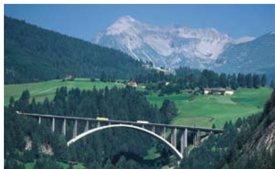
Most Nösslachbrücke, Avstrija (vir: BMVIT Alpenstraßen AG).
