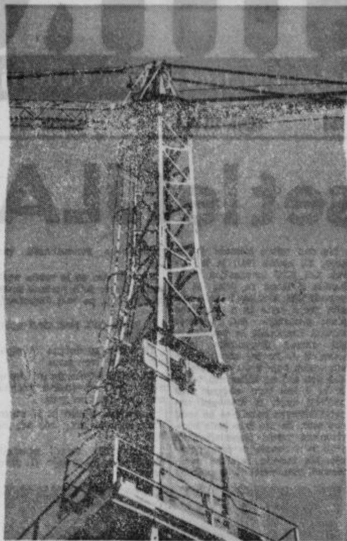
zerjav, ki opravlja avtlačne uslugе pri graditvi tovarne močnih krmil ob Zagrebški cesti v Ptuj
