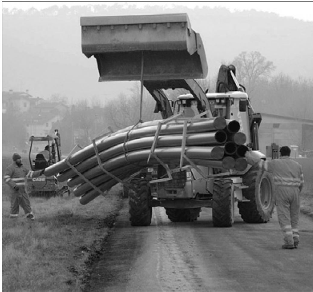
Delavci podjetja Edilgas med polaganjem cevi za plinsko omrežje
