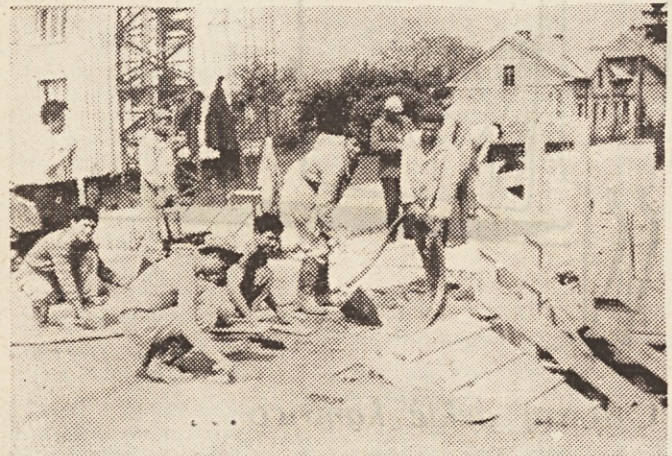
V Mariboru gradimo nov samski dom za 250 ležišč. Dela na objektu hitro napredujejo
