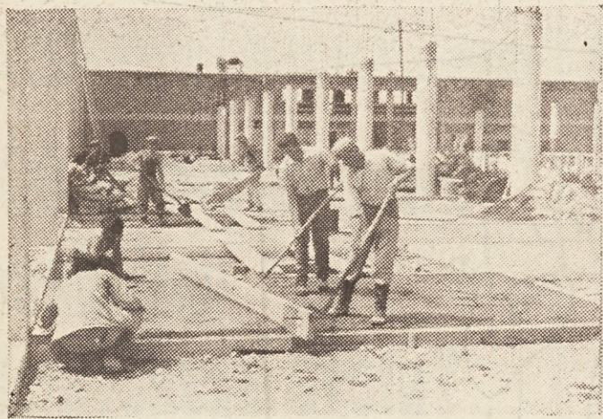
Na gradbišču Avtoobnove v Mariboru
