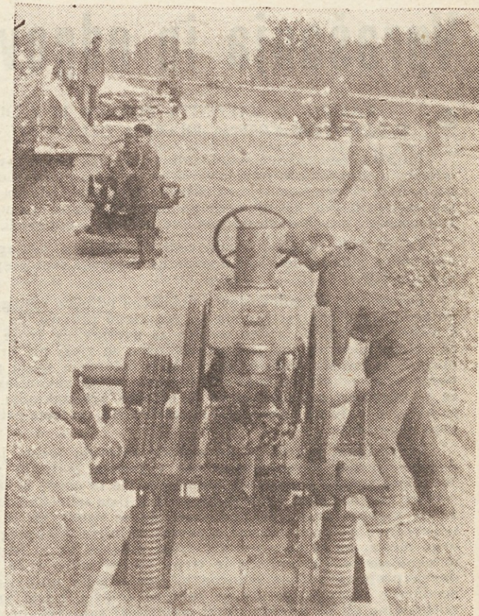
Na gradbišču v Mednem vsa mehanizacija v pogonu
