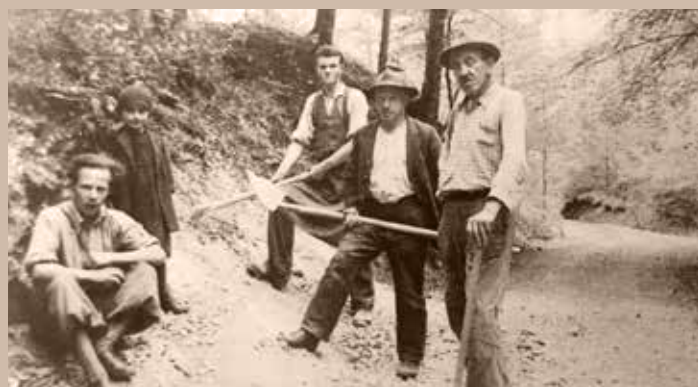
Dobenci pri gradnji ceste Dobeno–Loka 1939
