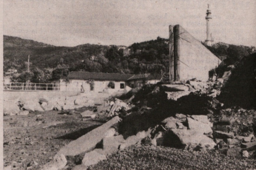
Zadnje silovito neurje je naredilo precej škode pri Tržaškem pomorskem klubu Sirena, ki je izgubil dve jadrnici, ena pa je razbita. Razbesnelo morje je s sabo odneslo precej terena, načelo valobran, razpoke pa so opazne tudi na drči
