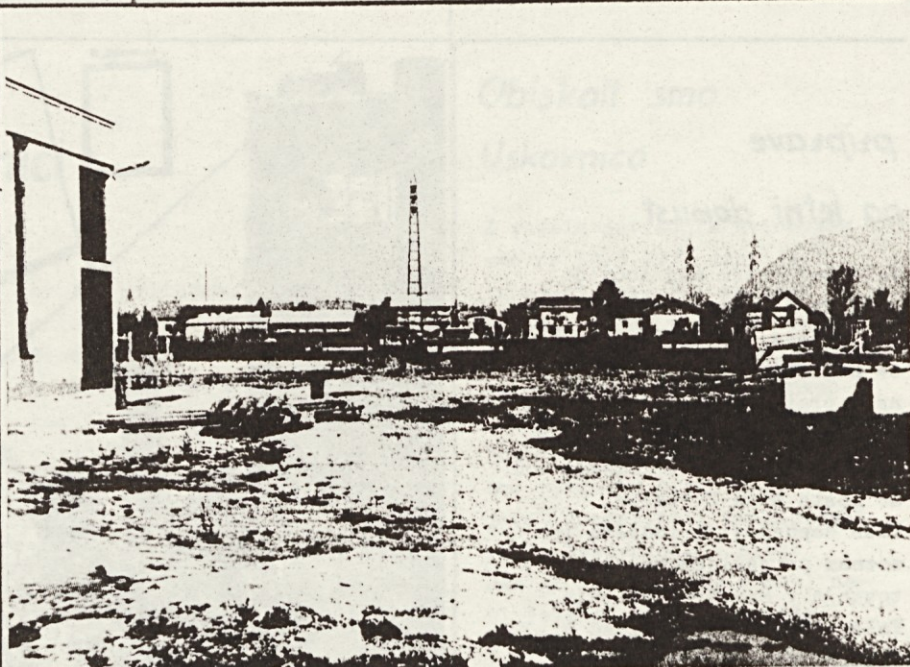
Prav na tem mestu, ki že danes ni več takšen kot je na fotografiji, bo stala upravna zgradba. V tem času je izkop za kleti že gotov.
