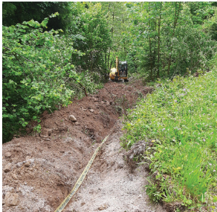
Gradnja optičnega omrežja v Prvinah.
