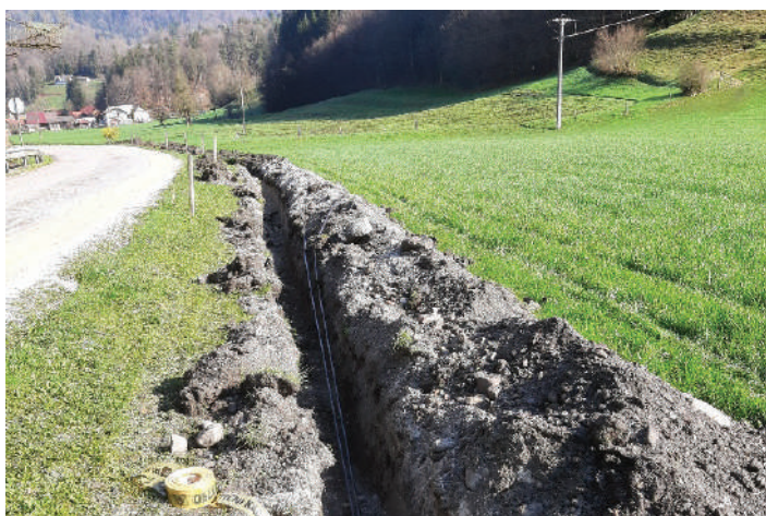
Gradnja optičnega omrežja v Zlatenku.
