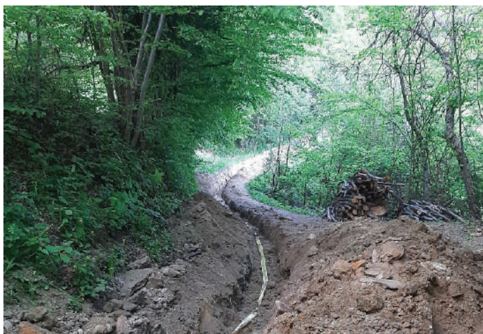
Gradnja optičnega omrežja Češnjice-Lipa.
