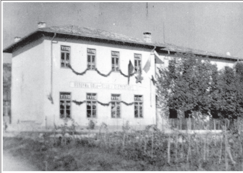
Stavba osnovne šole Sv. Peter (od 1954 do 1992 Raven – Sečovlje). (SŠM, fototeka, inv. št. 2375)
