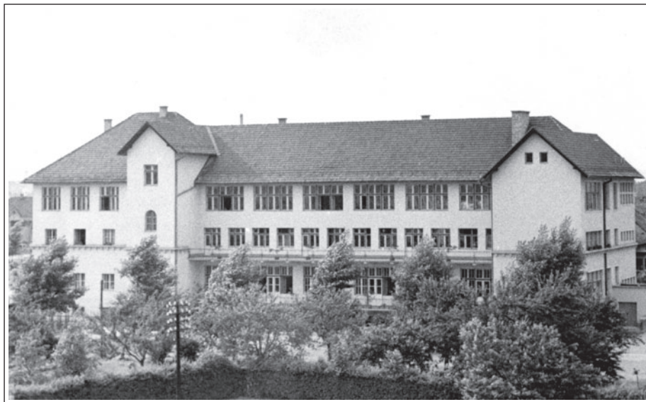
Stavba osnovne šole v ljubljanskih Mostah. K prvotni stavbi meščanske šole je bilo prizidano drugo nadstropje, ki je bilo 6. septembra 1958 slovesno odprto in poimenovano po Vidi Pregarc. (SŠM, fototeka, inv. št. 1119)
