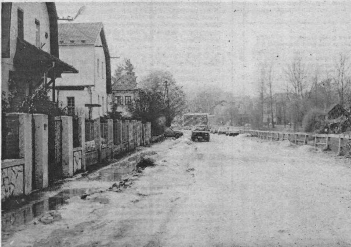
Makadamska cesta Ob Ljubljanci še vedno močno greni življenje prebivalcem ob njej. Namesto pločnika so imeli ob taljenju snega velike luže, ki pa zaradi profila ceste ne morejo odteči v bližnjo Ljubljano. Razumljivo je tudi, da je taka cesta zelo zoprna za pešce, saj marsikdo konča hojo po njej v oškropljenem ali drugače zamazanem oblačilu, ki ga je povzročilo mimo vozeče vozilo. Pa ne vedno po krivdi voznika.
