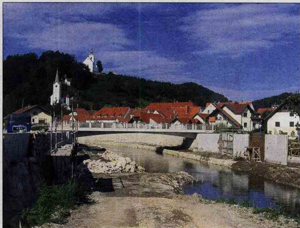
Močni nalivi so doslej izvajalcu protipoplavnih zaščit v Vojniku že tretjič naredili kopico težav, zaradi katerih so morali gradbena dela ustaviti. Jih bodo morali tudi zaradi trdih pogajanj z lastniki zemljišč?
