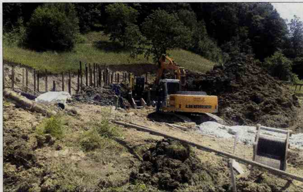
Sanacijska dela na plazu
