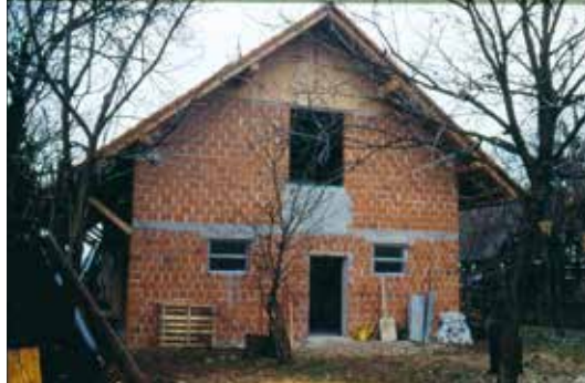
Novi svinjak v gradnji
