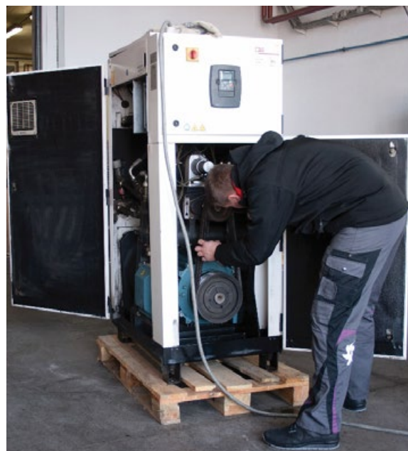
Slika 2. Servisiranje vijčnega kompresorja
