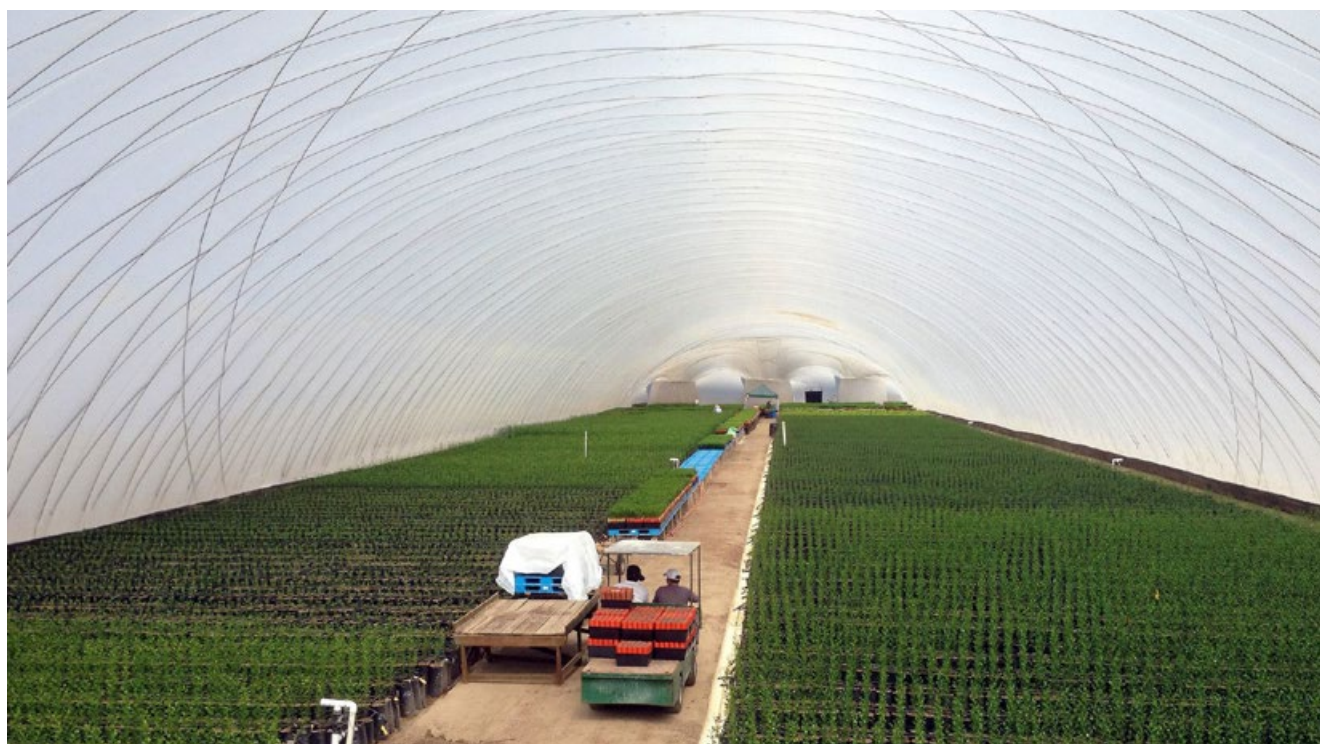
GreenDome – nova generacija rastlinjakov za prekritje velikih površin. Stalni dotok kontroliranega in filtriranega zraka omogoča idealno mikroklimo ter organsko gojenje rastlin.
