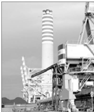
Tržiška termoelektrarna BONAVENTURA
