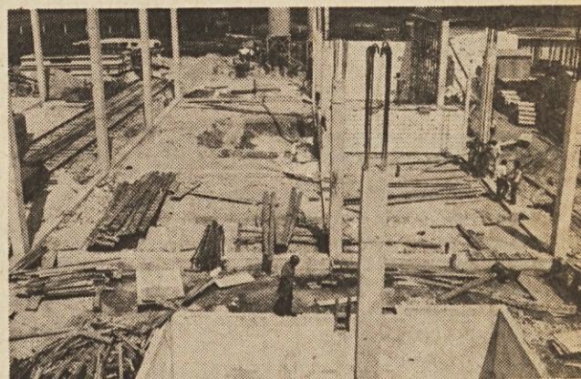
Konec septembra bodo pri novi livarni v Ivančni gorici že začeli montirati pripravo peska in tehnološko opremo.
