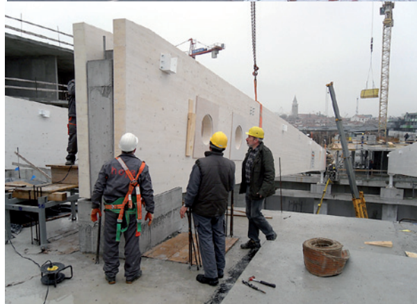
Transport in vgradnja 44-metrskih lepljenih nosilcev podjetja HOJA d.d. (foto: HOJA d.d.)
