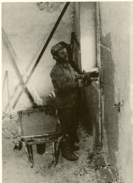
MRZELJ Anton opravlja zidarska dela v novem garderobnem prostoru
