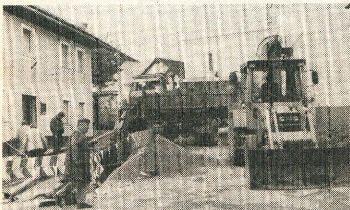
Gradnja in obnova vodovoda se uresničuje po referendumskem programu. Na Drenovem griču so že končali z obnovo cevovodov, konec maja pa so že začeli z deli na novem cevovodu za Partizanski klanec.
