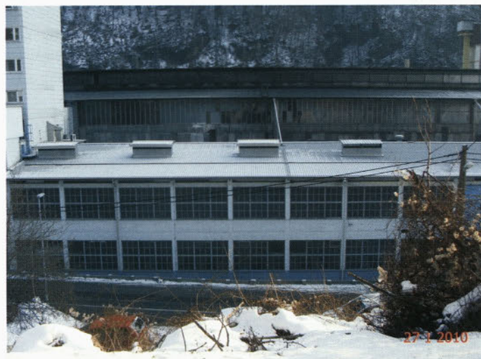
Na sliki je hladni del Vitruma z dvokapno streho, kjer je že vgrajenih nekaj odvodnih jaškov, ter sprednja stena z zazidanimi dovodnimi odprtinami, kamor bomo vgradili nove.
