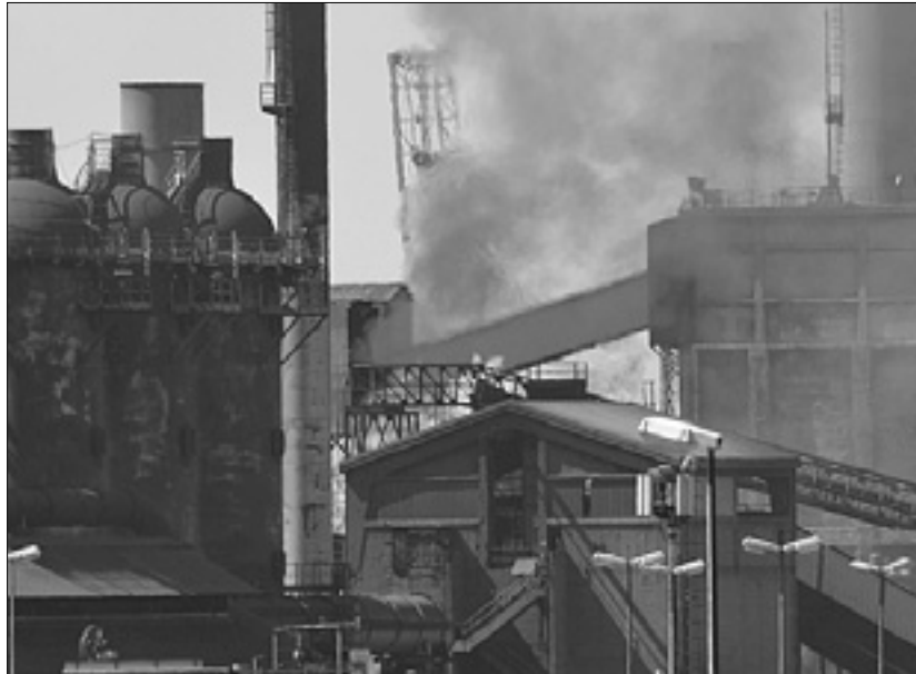
Pogled na škedenjsko železarno
