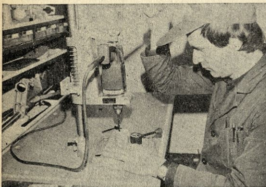
Slika 4. Z vrtnikom, ki je vpet v vertikalno stojalo, izvrtamo izvrtine \varnothing 9 v del 5, ki je vpet v primež
