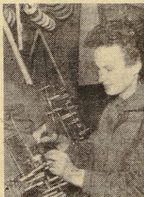
Delavka pri pletenju žičnih oblik za ATC
