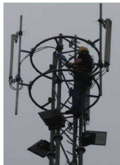
Slika 3: Delo na višini pred antenami baznih postaj
