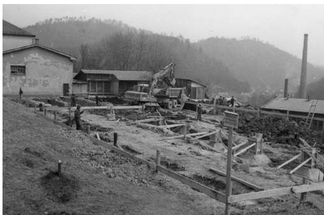
Gradnja - povečava učne delavnice (850 m 2 ) iz leta 1974
