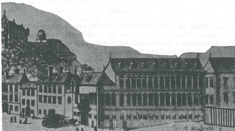
Ljubljanski dvorec deželnih stanov — lontovž, na oglu Novega trga in Gosposke ulice. V medtem predelanem levem, vogalnem traktu je zdaj sedež Slovenske akademije znanosti in umetnosti; desni, višji trakt je bil podrt zaradi poškodb po potresu leta 1895
