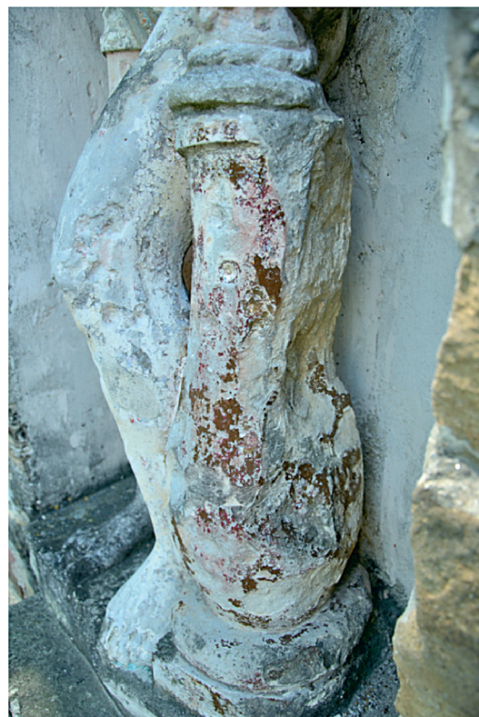
Poškodbe – spodnji del plastike. Foto: Nina Mertik.
