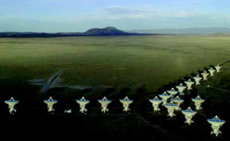
Največji radijski teleskop na svetu se nahaja v Novi Mehiki in ga sestavlja 27 paraboličnih anten - vsaka od njih meri 25 m v premeru ...
