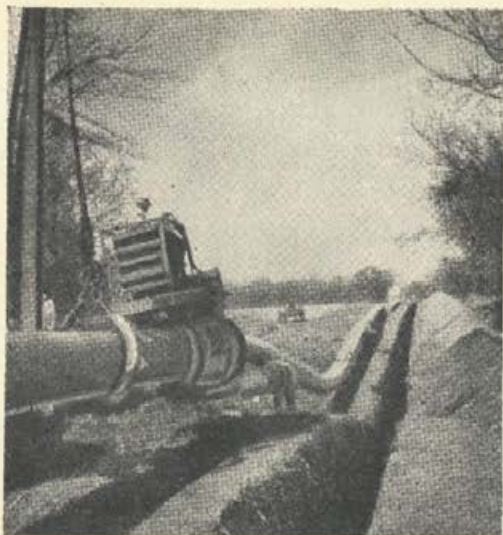
Polaganje cevovoda za nafto. — V Arabiji so cevovodi na površju.
