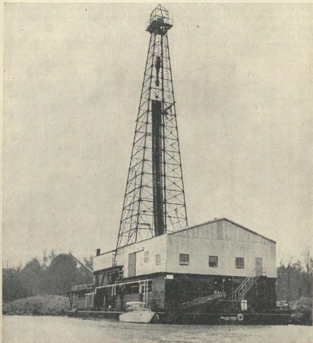
Vrtalni stolp na splavu na vodi
