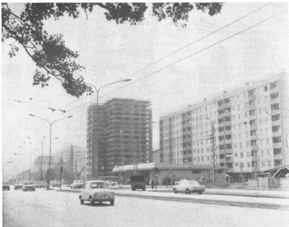
Novogradnje ob Celovski cesti
