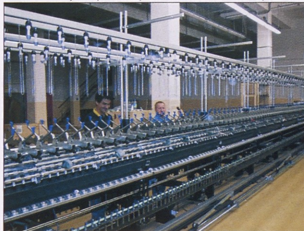
Montaža novih predilno-previjalnih strojev
