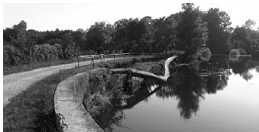
Oporni zid je v loku zdrsel v tok Timave
