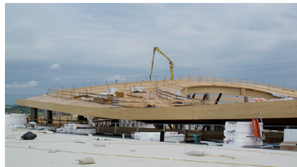
Gradnja nakupovalnega središča G3 Shopping Mall, Dunaj (foto: M. K. Kuzman)
