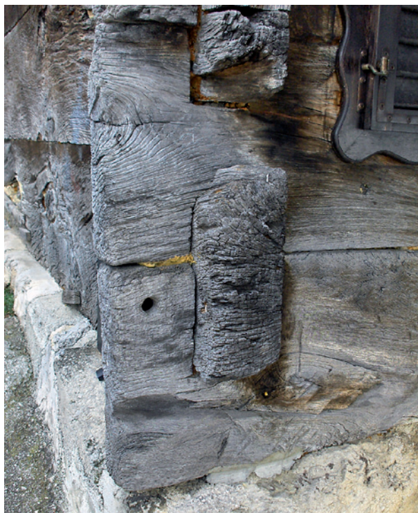
Vogal kladne konstrukcije brun z vezavo na škrinjco (foto: V. Hazler, 19. 1. 2007)
