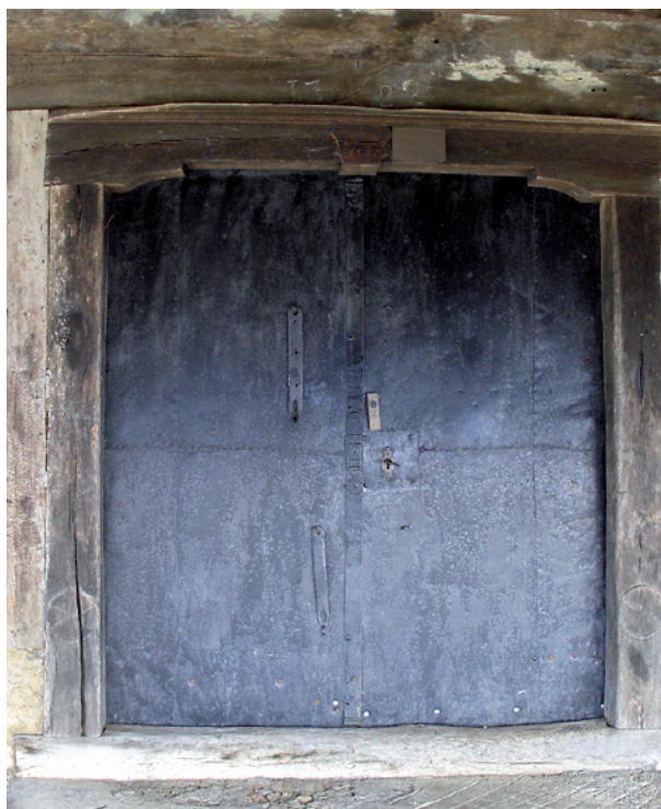
Glavni vhod s pločevino prekritima vratnima kriloma in letnicama 1722 in 1880 (foto: V. Hazler, 19. 1. 2007)
