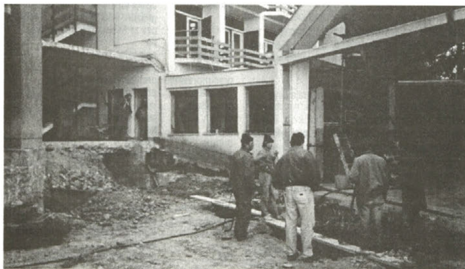
Izkopavanje temeljev za recepcijo
