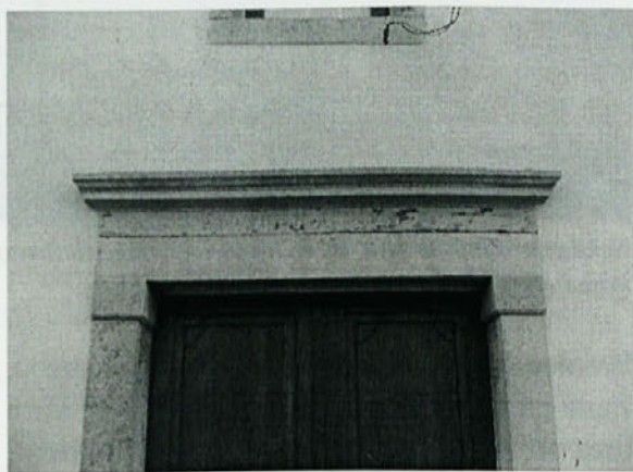
Kamnit portal na stavbi šole na Planini, na katerem je vklesan napis: LJUDSKA ŠOLA (Foto: F. Černigoj)
