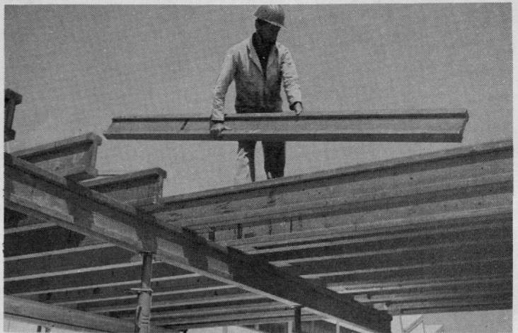
Podporje iz nosilcev za opaž betonske plošče
