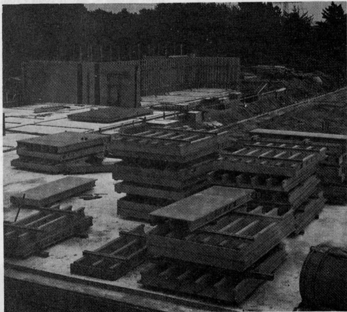
Opož iz nosilcev in plošč za opaženje betonskih sten
