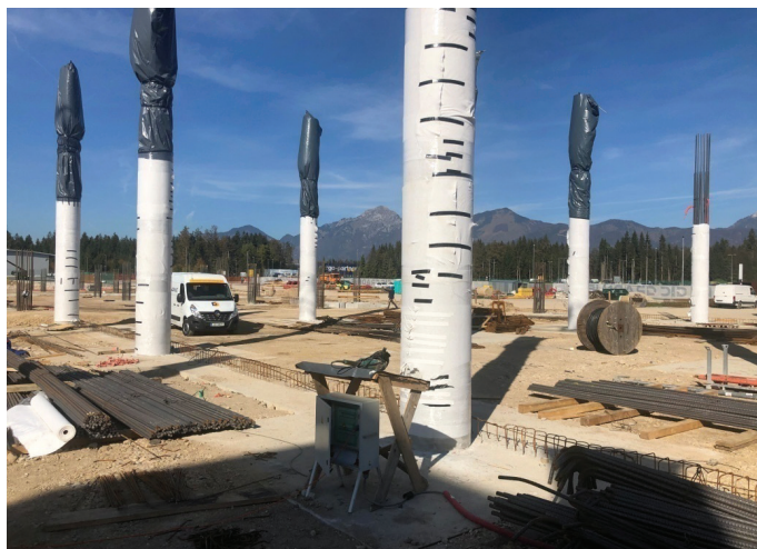
Slika 15 • Zaščita in nega AB-stebrov po razopaženju.
