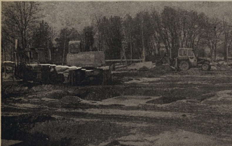
16. februara smo fotografirali še zadnje izkope za izdelavo temeljev za stebre nove tovarne gradbene opreme v moščanski industrijski coni MP-3
