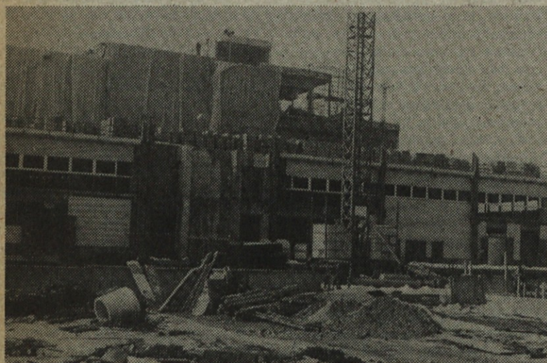
Del objekta v prvem in drugem nadstropju je zaprt, da se lahko izvajajo dela v notranjosti
