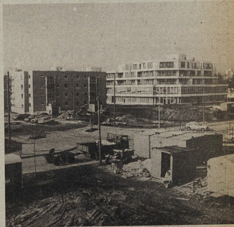
Gradimo novo stanovanjsko naselje v Goldsteinu pri Frankfurtu
