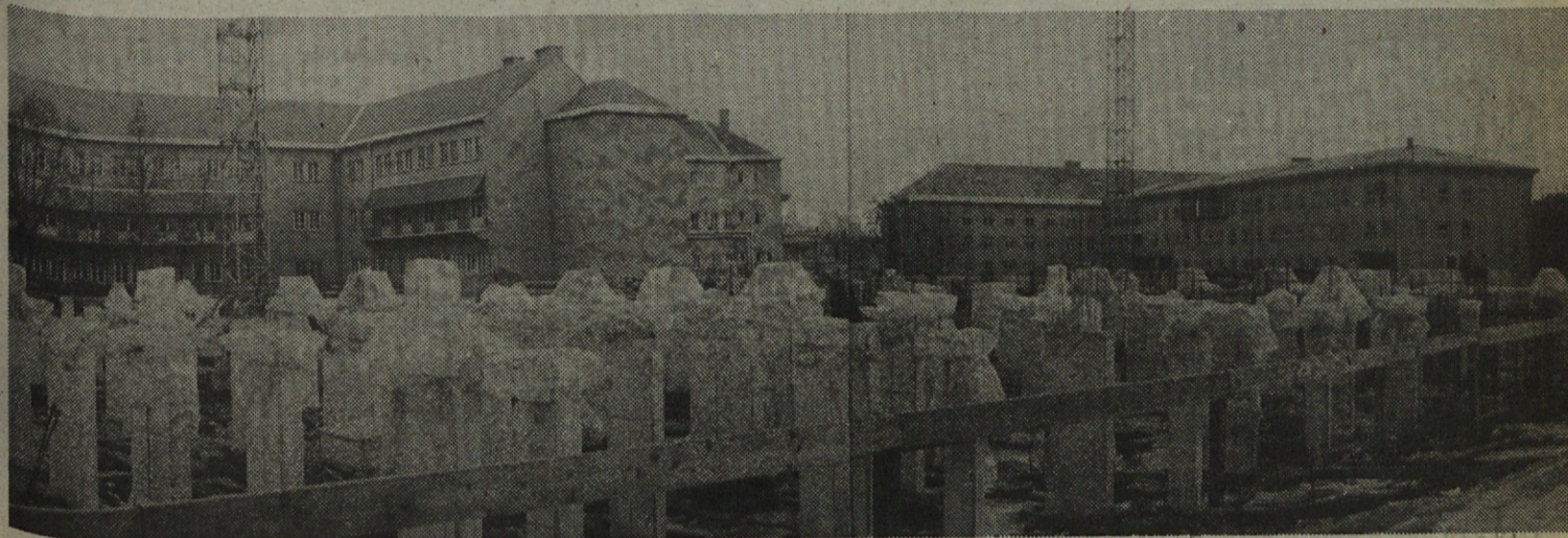
Gradbišče nove bolnice v Celju
