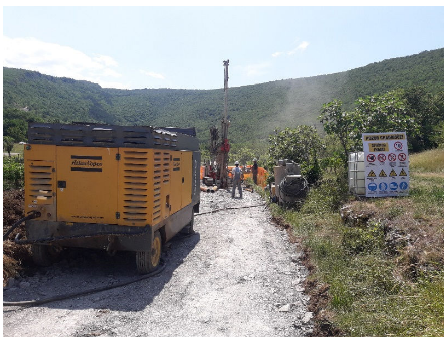
Slika 2. Vrtanje vrtnice v prispevnem zaledju Rižane z namenom nadzora in varovanja vodnega vira pitne vode; julij 2019
