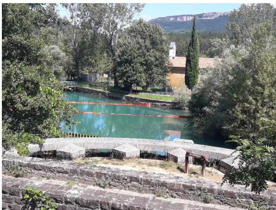
Slika 1. Izvir Rižane z nameščenimi plavajočimi pregradami za preprečevanje ali omejevanje širjenja naftnih derivatov po vodni površini kot posledica izlitja kerozina v podzemlje v prispevnem zaledju izvira junija 2019 Figure 1. Rižana spring with floating water barriers to prevent or limit the spread of petroleum products across the water surface after kerosene spill in the catchment area of the spring in June 2019
