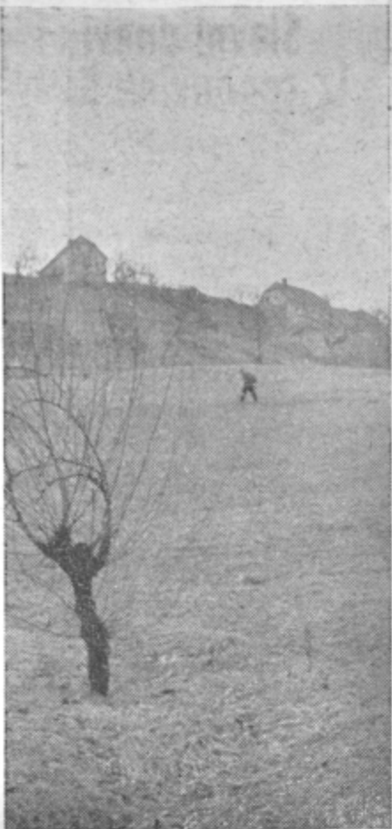
Kot zaseda negibnih vojakov so po greben hriba posejane kompolske hiše. Po tem rebro bo položena ena izmed vej bodočega kompolskega vodovodnega omrežja.
