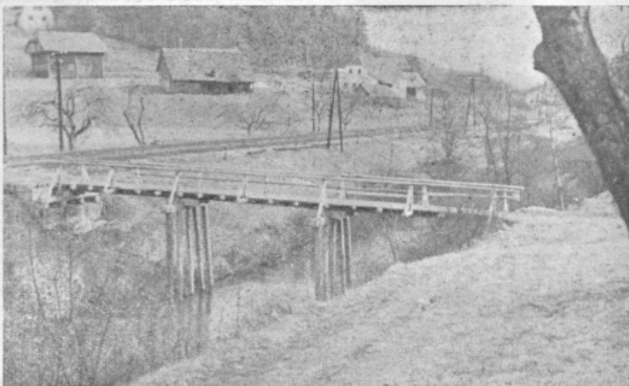
Nov most čez Voglajno je prehodan za pešce. Ko pa bodo položili plohe čez vso širino mostu, bo čezenj mogel vsak voz in celo lažji avtomobil.
