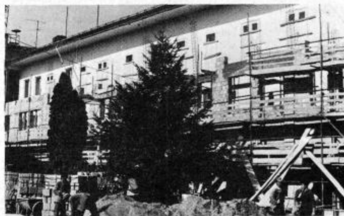
Delavci lenarškega Centrovida pridno delajo na prepotrebni adaptaciji občinske zgradbe.
