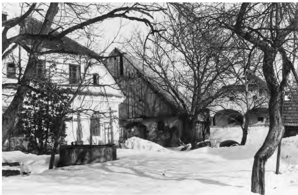
Ogrinova domačija v Mali Ligojni: levo hiša, pred njo vodnjak, desno hlev in kašča, februar 1984 (foto: Bojan Petrovčič).
