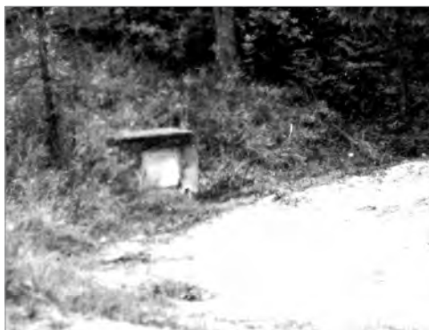
Rezervoar v Mali Ligojni, februar 1984 (foto: Bojan Petrovčič).
