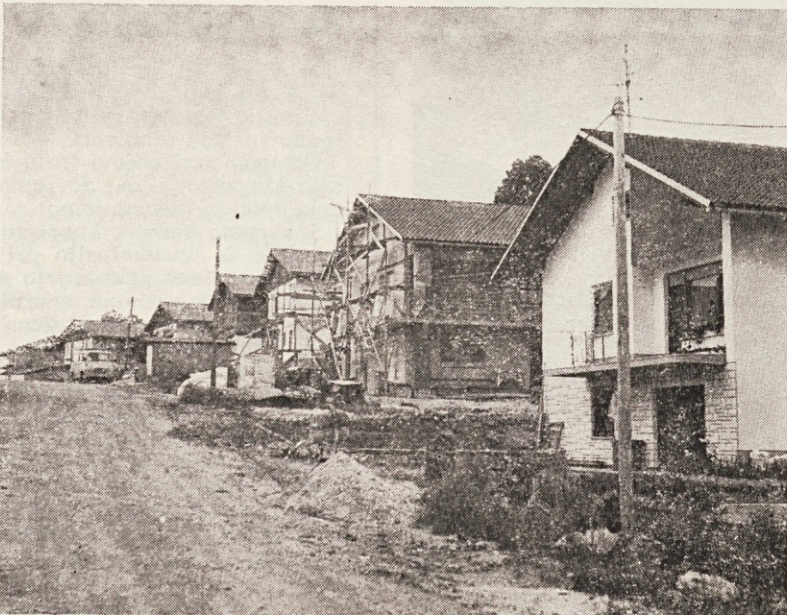
Gradbišče na Svinji gorici v Cerknici
