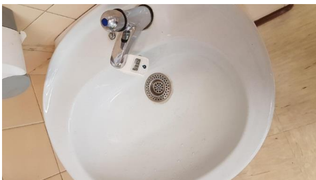
Slika 13. Merilnik porabe vode na pipi v razredu. Avtor: Mojca G. Štemberger.
