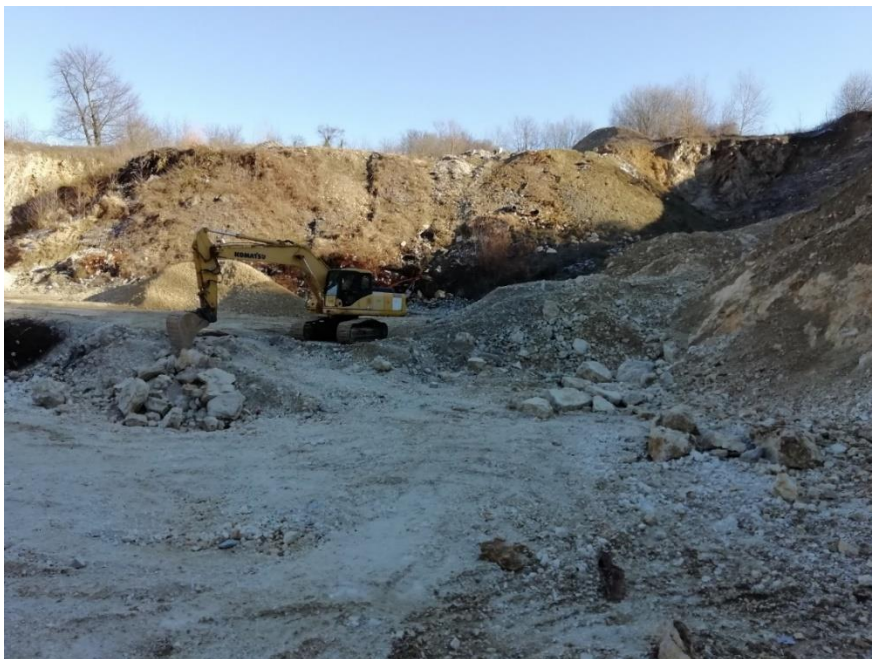
Slika 3. Fotografija kamnoloma iz februarja 2021. Pogled čez spodnjo etažo nekdanje jame proti večjemu nasipu gradbenih odpadkov iz katerega je bila posneta prejšnja fotografija. Jama je potekala v liniji čez bager pod zadaj stoječ nasip odpadkov. Avtor: Igor Bahar.
