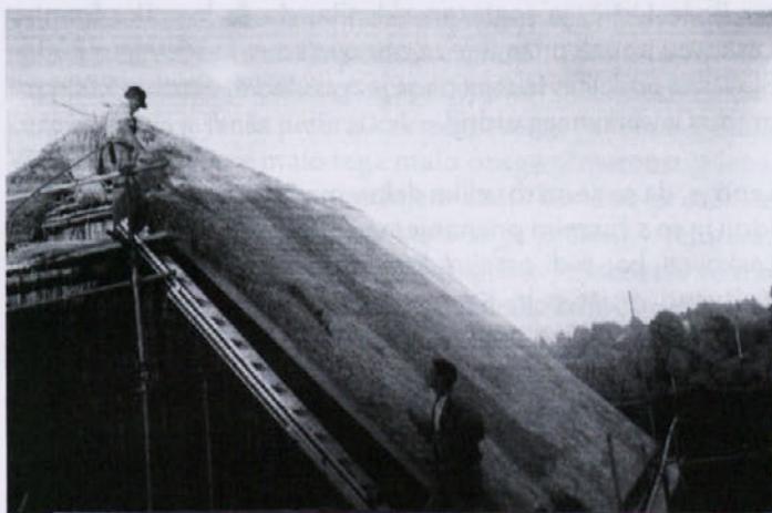
Izdelava slamnate strehe. Foto: Primož Leskovec
