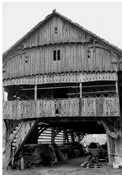
Slika 3. Hofov kozolec v Doliču - gank na čelu ne členi lepo same arhitekture, ampak omogoča dostop v vrhnji prostor
