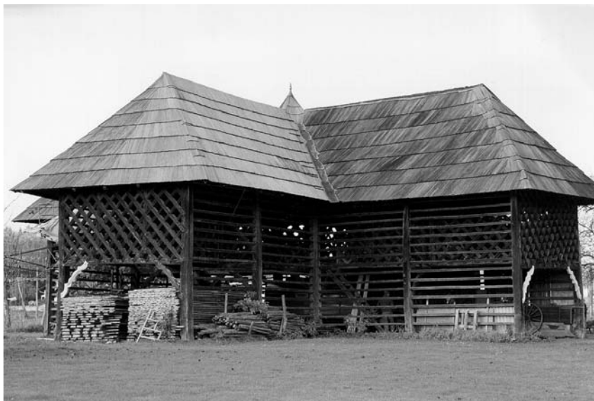
Slika 1. Marovškov dvojni - križni kozolec v Turiški vasi je poseben tip topolarja, ki ima tlorisno obliko grškega križa. Čas njegovega nastanka ni natančneje opredeljen, ljudsko izročilo pa ga postavlja daleč v 19. oziroma na konec 18. stoletja. Je edinstven primer v slovenskem in tudi širšem evropskem prostoru.
