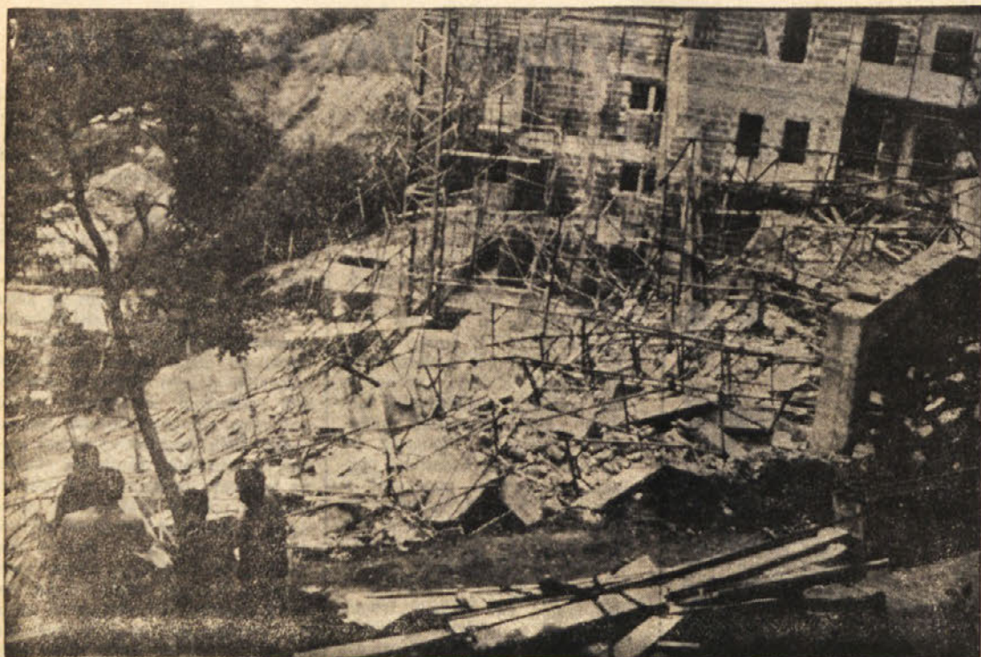
Porušena 6-nadstropna stavba na Brandežiji
