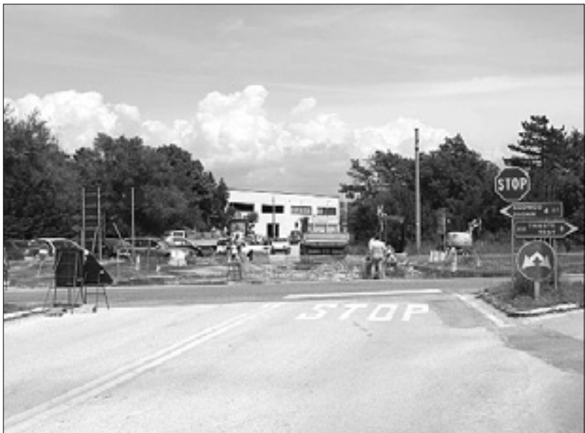
Popravilo ceste v križišču za Proseško postajo
